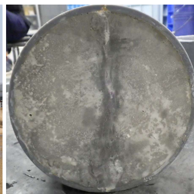
実験終了時（自己治癒完了） ひび割れ幅0.25mm、漏水量0mL
