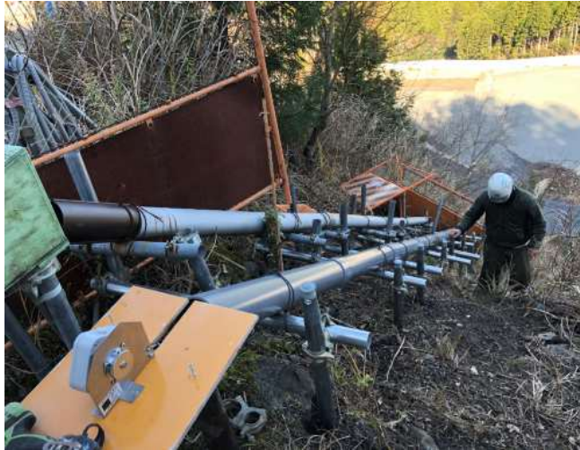
地すべり監視(全景)
