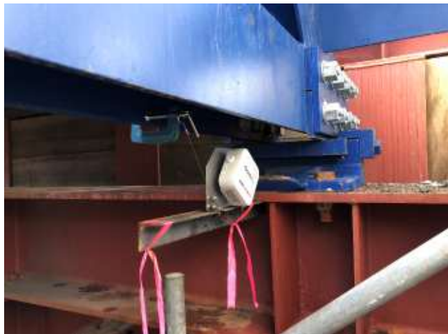
仮橋の挙動監視
