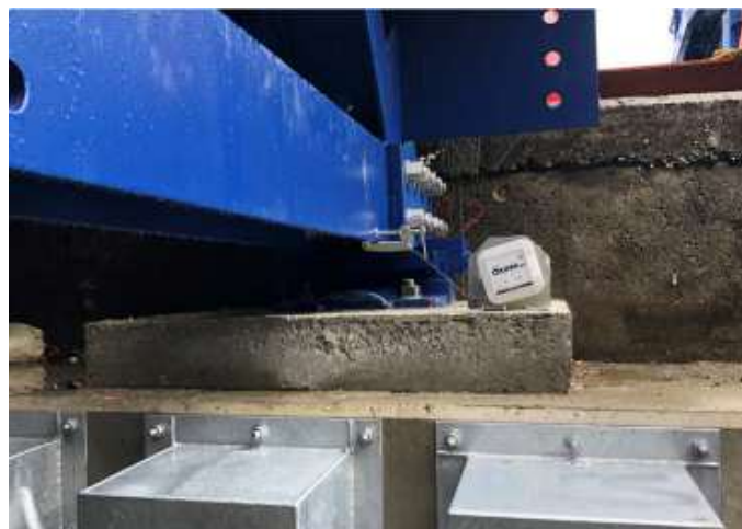
仮橋の挙動監視
