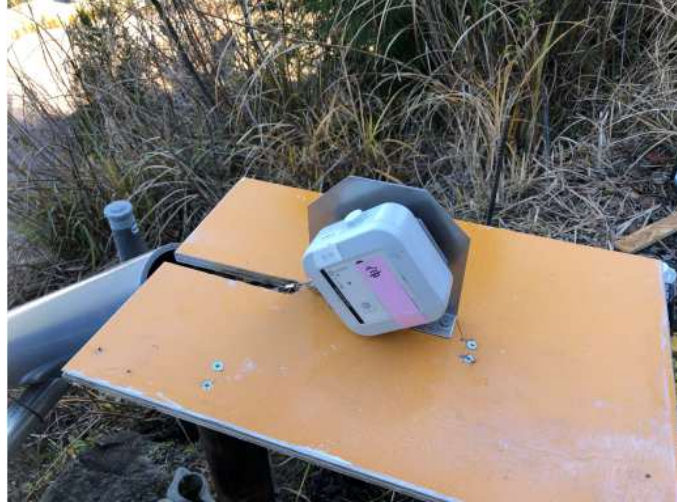
地すべり監視(近景)
