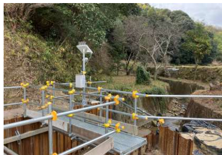
造成用地 仮排水路(雨量計)
