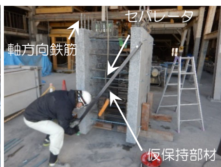
ユニット化した プレキャスト側壁部材
