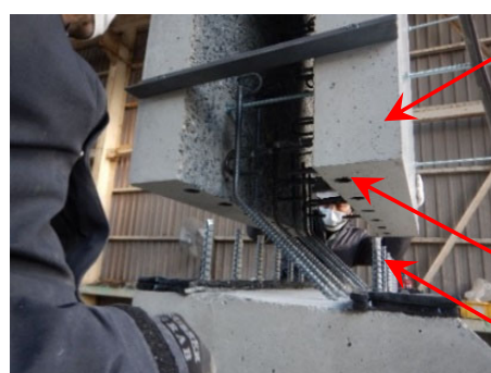
プレキャスト部材の接合状況（ハンチ部の場合）
